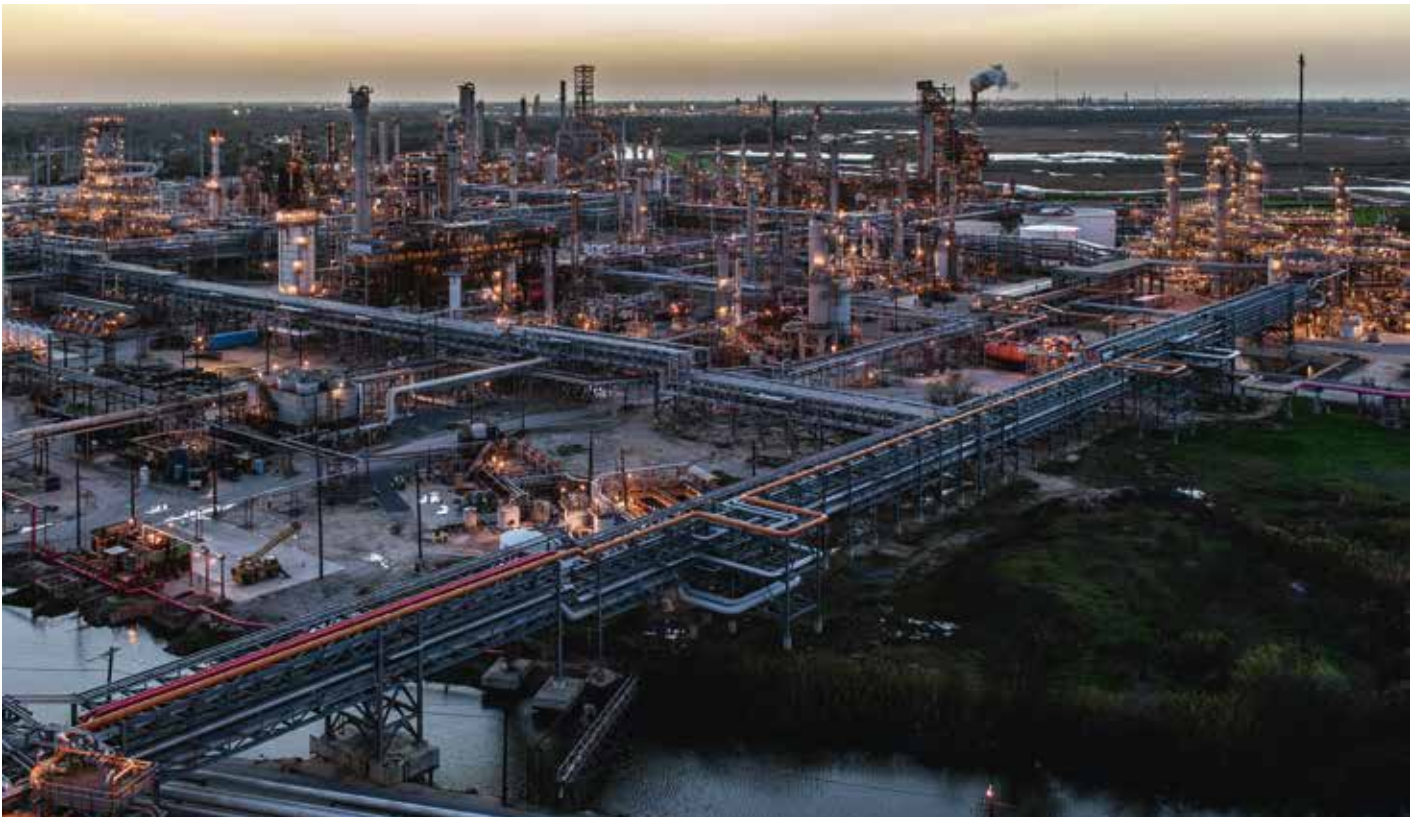
Raffinerie de Port Arthur, Texas, États-Unis.
